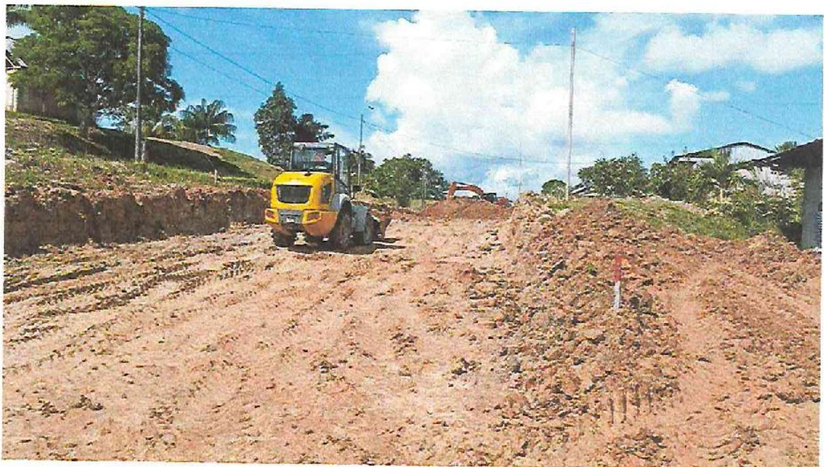
Conformación a nivel de Sub Base en la Localidad de Mazan
