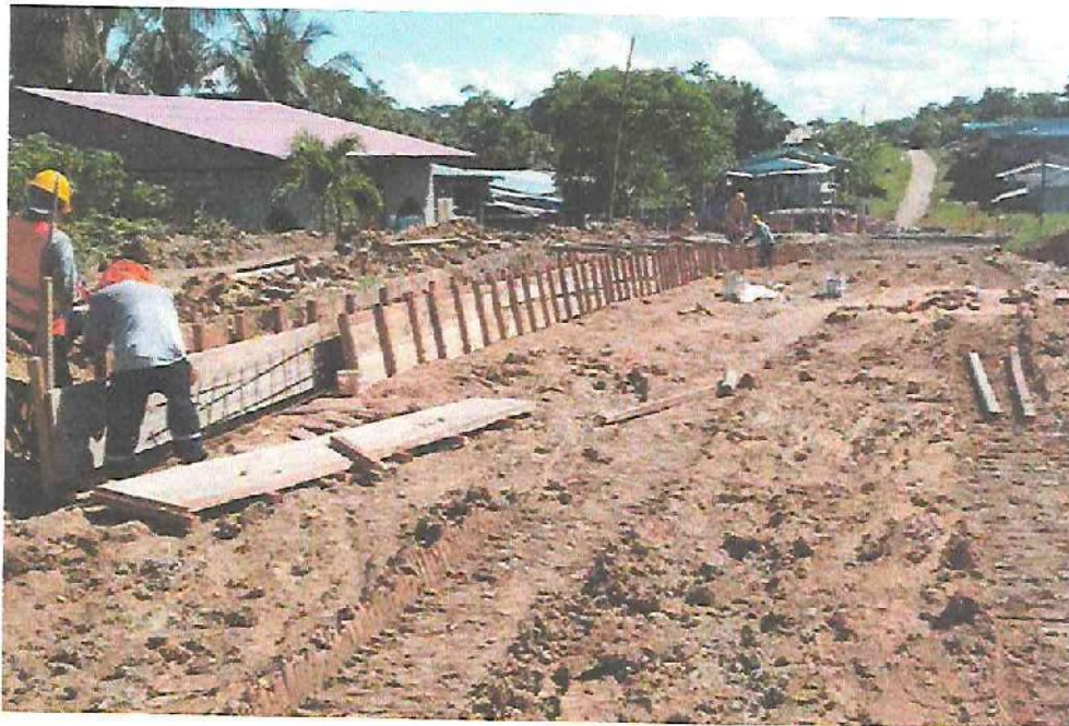
Encofrado para sardinel
