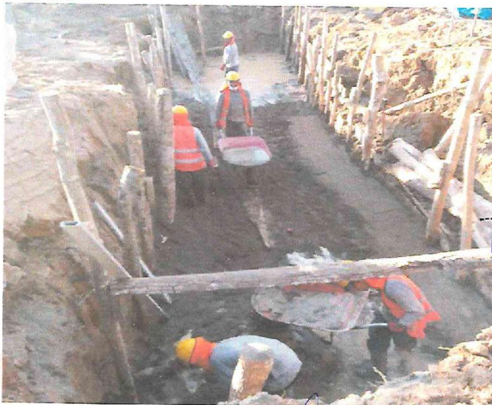
vaceado de mortero 1:8 para solado en alcantarilla de cruce
