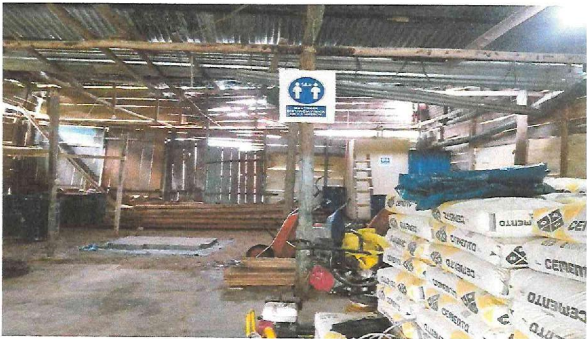
Acopio de materiales en el almacén de la Localidad de Mazan
