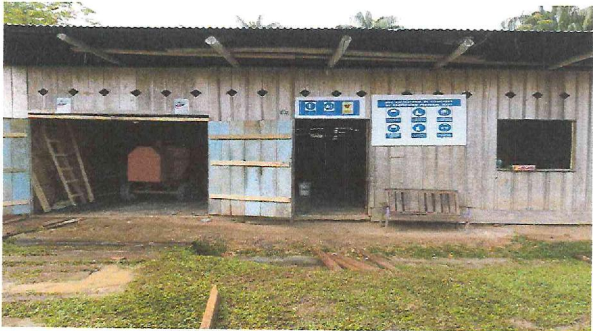
Almacén en la Localidad de Mazan
