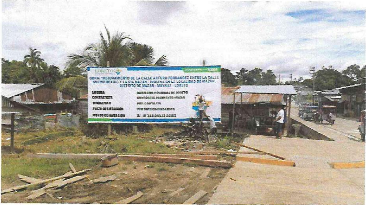
Cartel de Obra en la Localidad de Mazan
