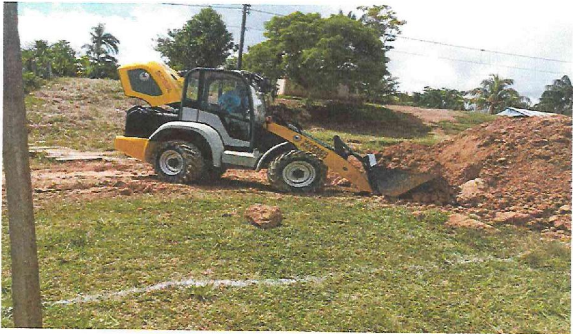
Eliminación de Material Excedente en la Localidad de Mazan
