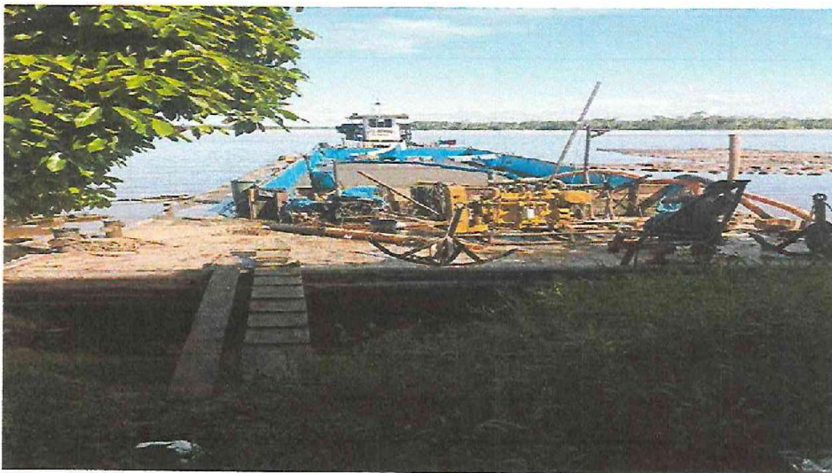
Acopio de Arena en la Localidad de Mazan
