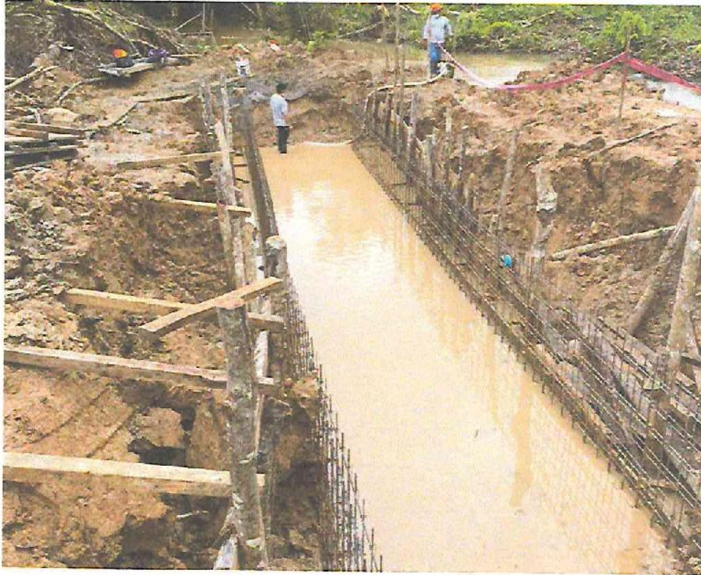
Colocación de acero para alcantarilla de cruce
