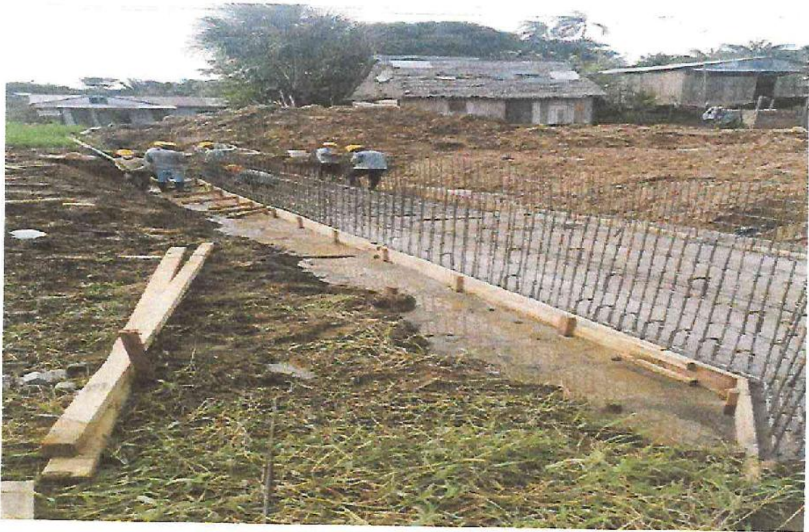
Alcantarilla de Cruce – Cama de Arena, Solado, Acero, Encofrado + Mortero en la Localidad de Mazan
