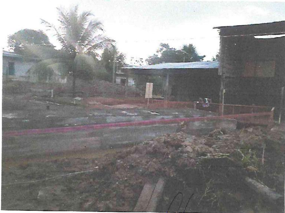
Desencofrado en alcantarilla de cruce
