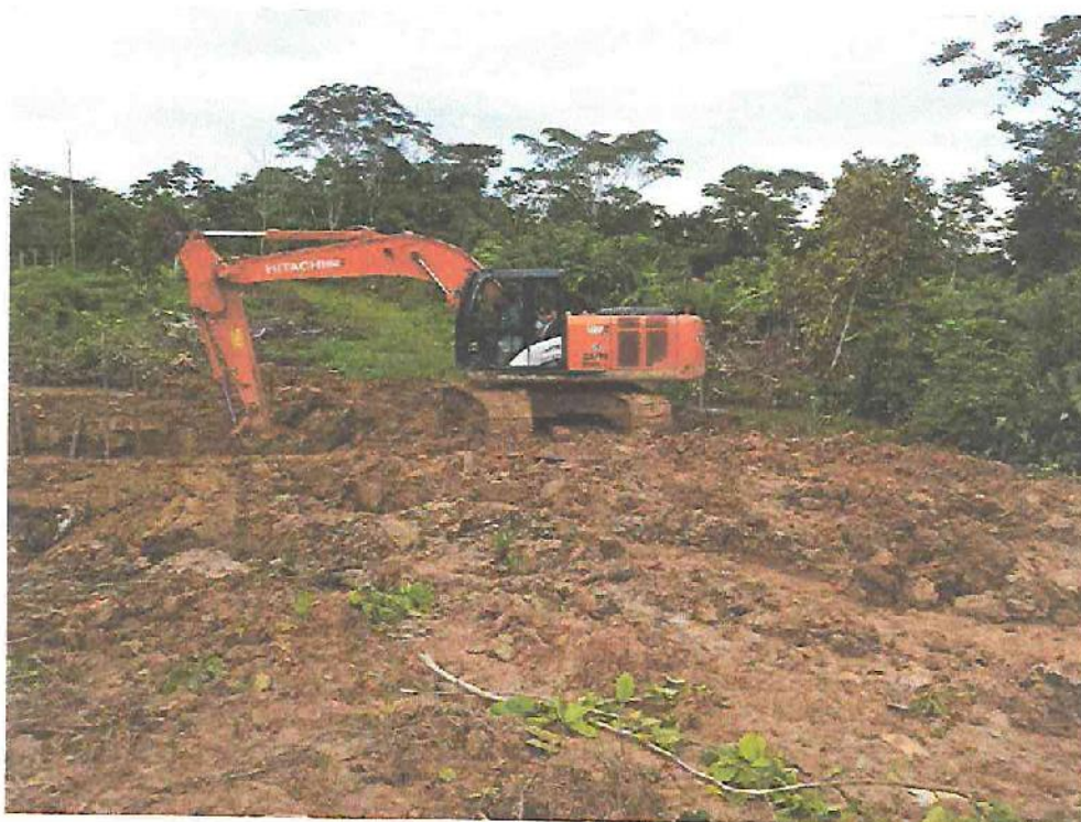
Corte de terreno a nivel de sub rasante
