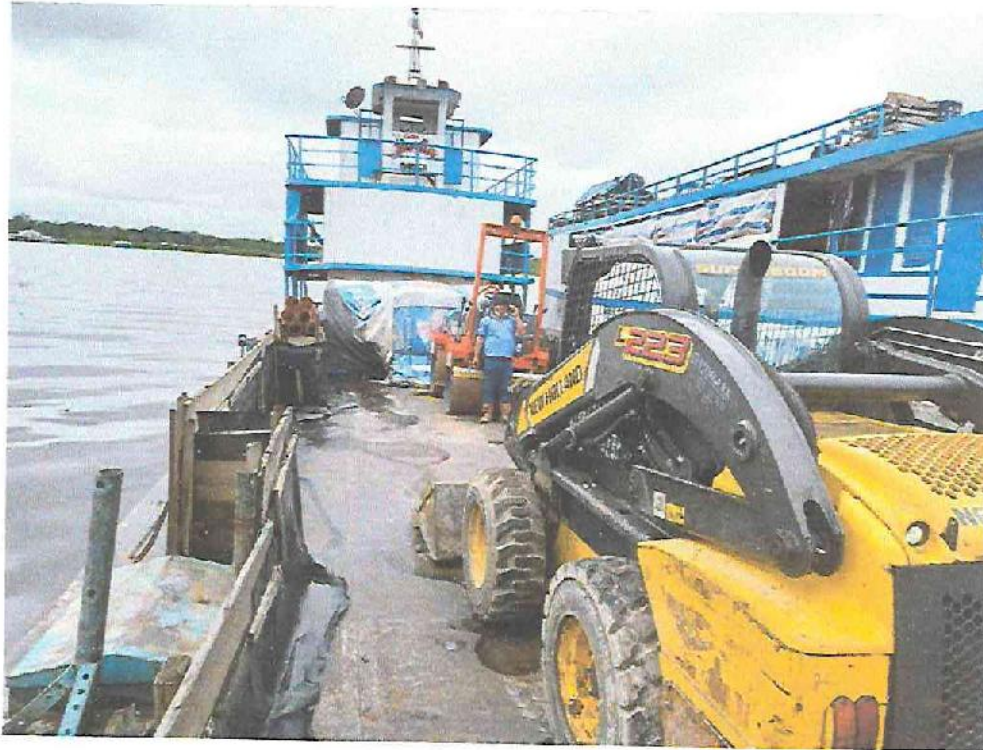
Transporte de materiales, equipos y herramienta a obra
