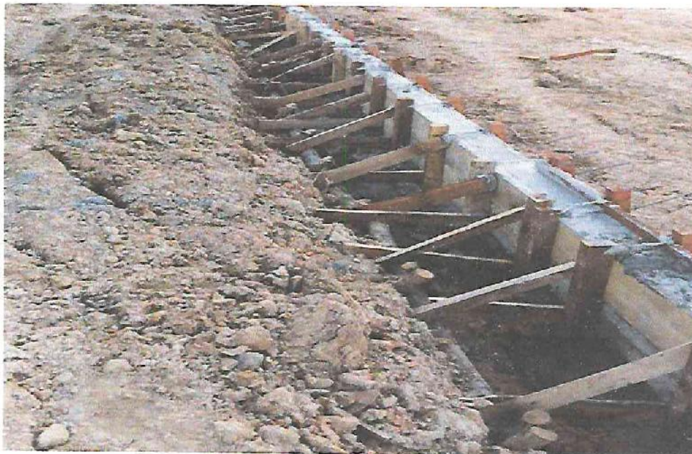
Vaceado de mortero F' C 175 kg/cm2 en sardinel
